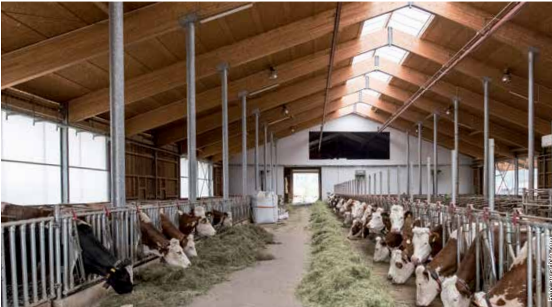
ÜBER DAS DACH kann zusätzlich Tageslicht in den Stall gelangen.
